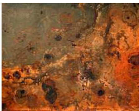
Corrosion d'une plaque d'acier
